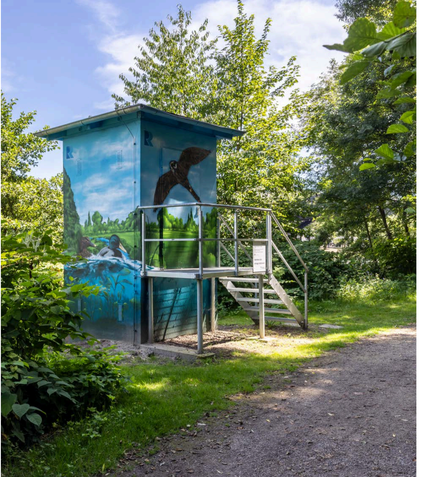
Die Pegel entlang der Ruhr, hier der Pegel Mülheim, liefern wichtige Daten für die Talsperrensteuerung im Ruhreinzugsgebiet. The gauging stations along the Ruhr, here gauging station Mülheim, provides important data for the management of the reservoirs in the Ruhr catchment area.
